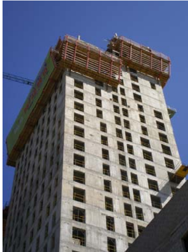
Fig. 2 Construcción. Encofrado trepante.
